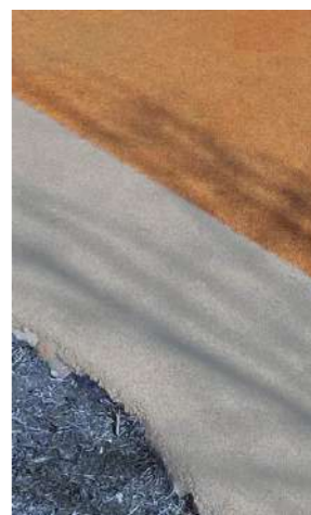
Резиновое покрытие - детская площадка, спортплощадка (соединение внахлест с бортовым камнем)
